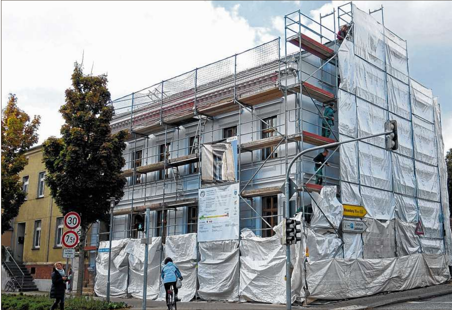
Was darunter verborgen blieb... Nach der Enthüllung des Eckhauses konnten Interessierte und Neugierige über die Baustelle flanieren.
